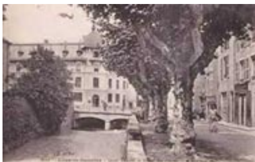
Le quai Thurel avant les travaux
